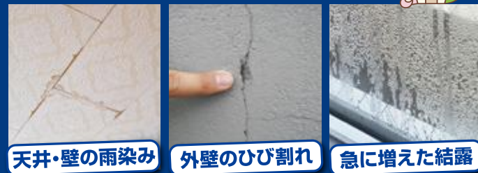
天井・壁の雨染み 外壁のひび割れ 急に増えた結露
