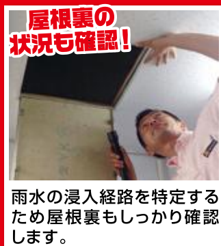
屋根裏の 状況も確認！
